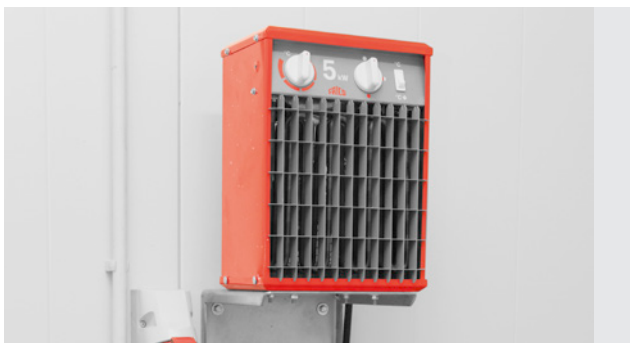
Die 5-kW-Heizung in nEx-Ausführung sorgt in Kombination mit der Wärmedämmung für eine Innentemperatur von + 5 °C bei –15 °C Außentemperatur.
