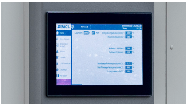
Zentrale Überwachung und Steuerung aller elektrischen Komponenten mit der DENIOS Communication Bar.
