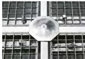
Kreuzverbinder - Abdeckung der Eckstöße bei z.B. 4 aneinander stoßenden Elementen
